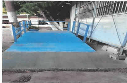
Foto 2: RAMPAS PARA ACCESO DE AULAS
