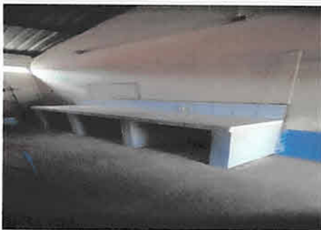
Foto 5: MESÓN DE CONCRETO
