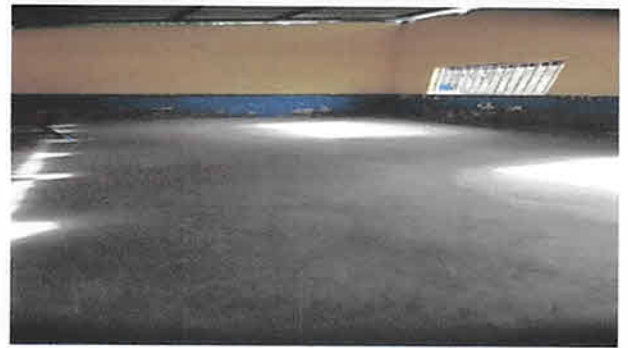
Foto 4: NUEVO PISO EN AULA
