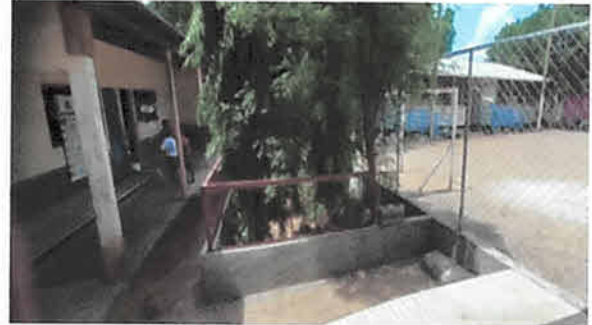
Foto 2: BARANDAS DE METAL EN EL AREA DEL JARDIN
