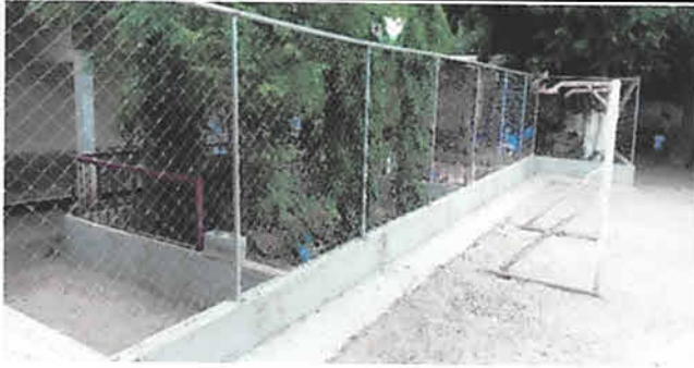
Foto 1: MURO CON MAYA GALVANIZADA
