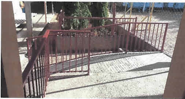
Foto 3: RAMPA DE ACCESO A LAS AULAS
